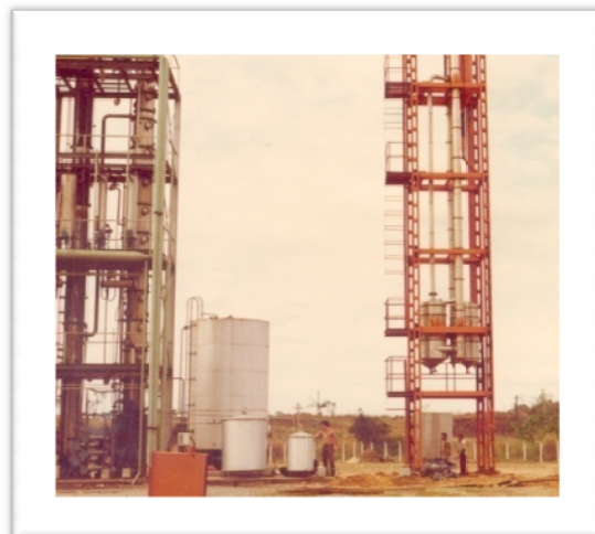
1. Usina de álcool: 2mil litros. 2. Evaporador de múltiplo efeito.
