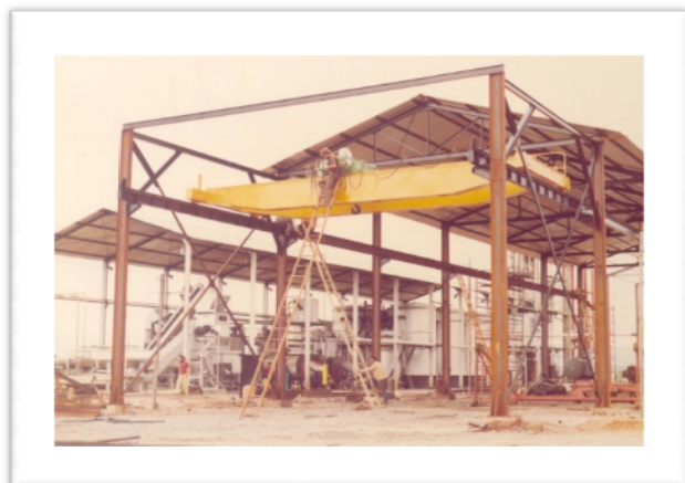
Sistema de moagem de cana de açúcar da usina de álcool. Capacidade de produção: 5 mil litros.
