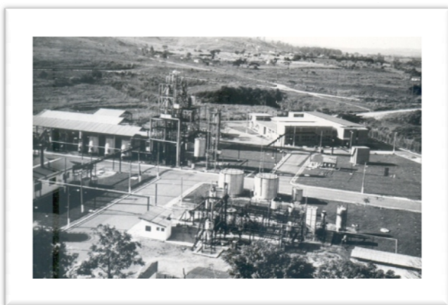
Vista panorâmica da usina. Ao fundo o prédio do Departamento de Biotecnologia. (1980)
