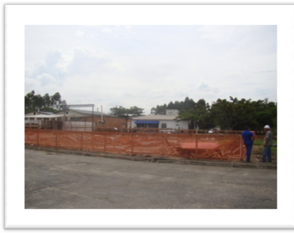
O recomeço: início das construções do prédio dos novos laboratórios didáticos da EEL (2011)
