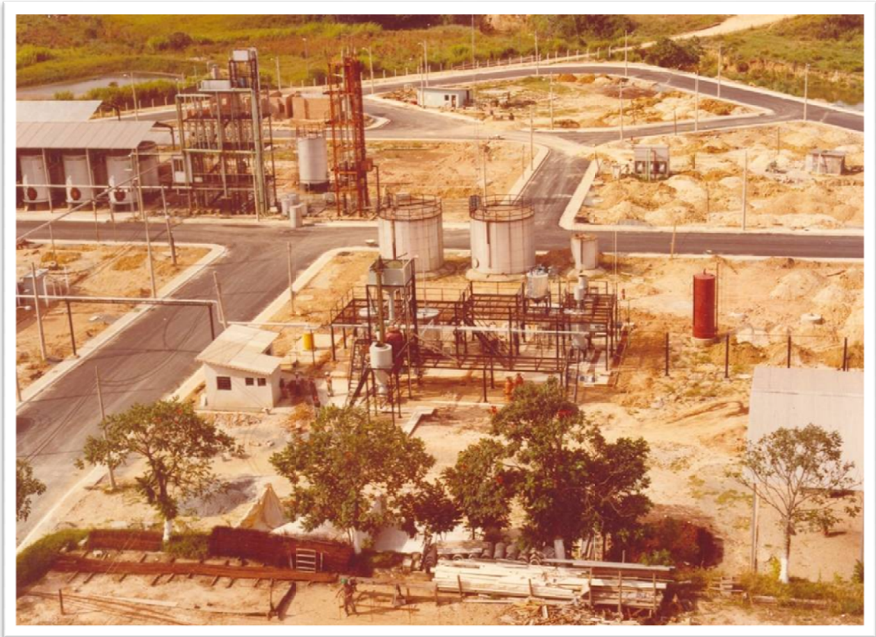
Construção da Usina Piloto/ FAENQUIL Fonte: Acervo-Memória/EEL
